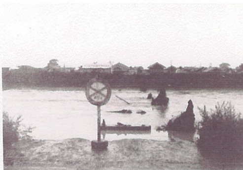
昭和42年豪雨 あげほの橋流出状況
