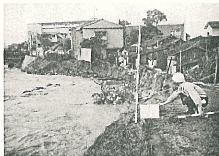
(豊中市千里川箕輪橋上流・府土木部)
