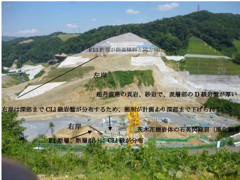
図2 ダム堤体の位置を示す写真、堤高76.5m、堤頂長337.5m、堤堆積約222万m 3 仮排水路トンネル273.2m、谷口部52.6m、非常用洪水吐きL=428.6m、ダム天端131.5m、最低水位90.2m
