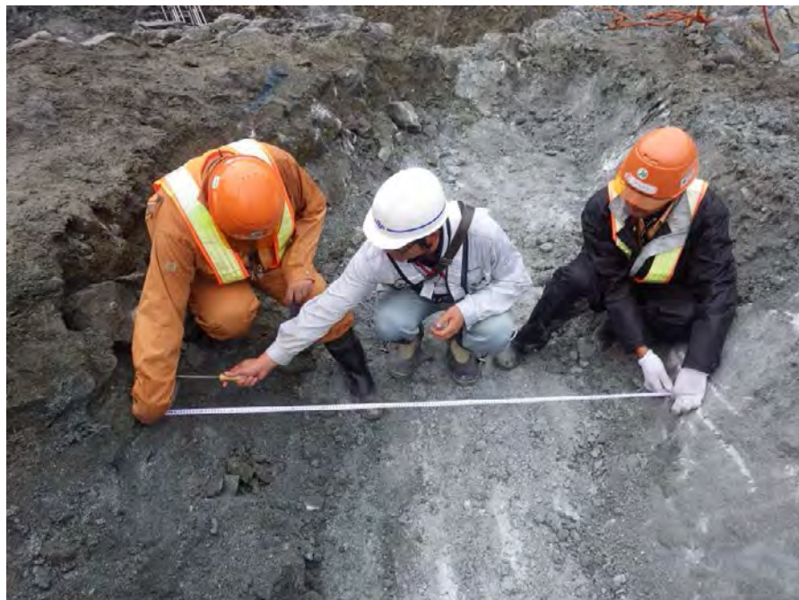
写真- 3.1.8 河床部下流側コアフィルター敷きの F-6.1 断層（設計仕上掘削面） D 級岩盤を含む CL1 級岩盤が最大幅で 170cm 程度分布する。
