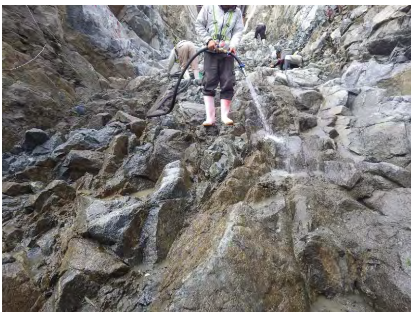
写真- 3.1.21 No.12+10・DC±0 付近の CM 級岩盤
