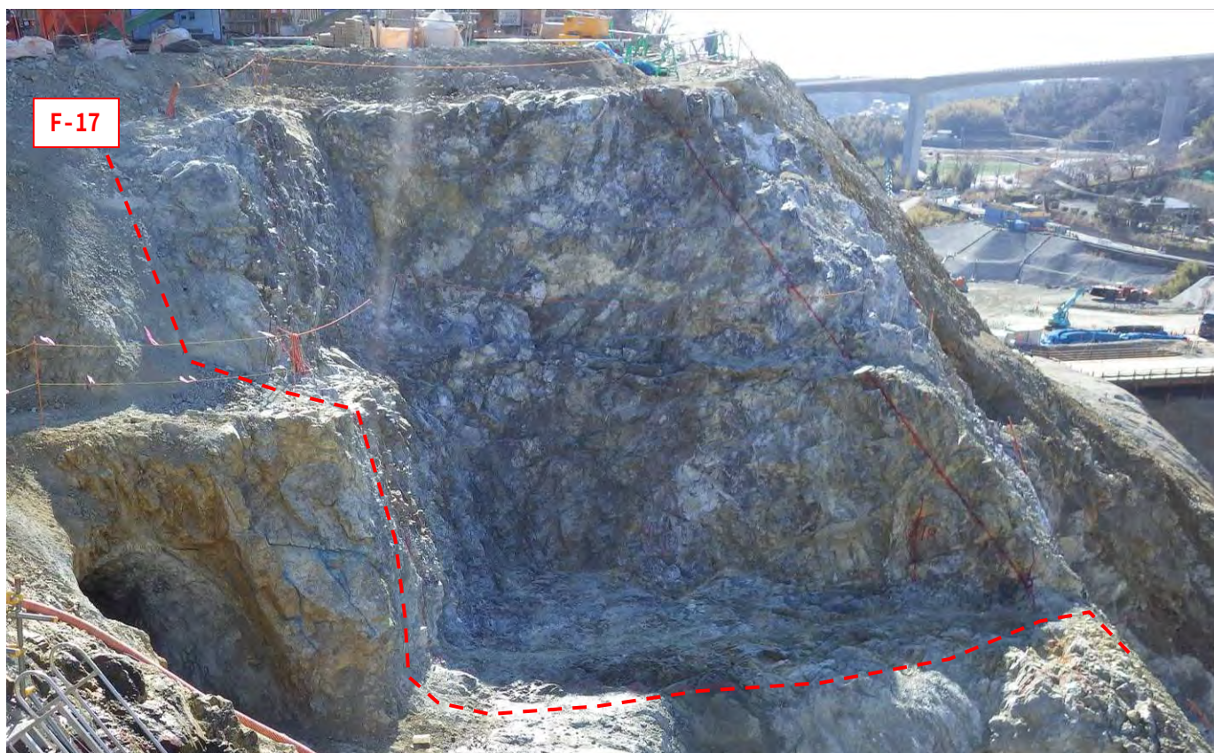
写真- 3.1.12 No.18 測線付近のコアフィルター敷き（下流側） 設計時に想定されていた CLl 級岩盤は掘削除去され、CM 級岩盤主体となる。
