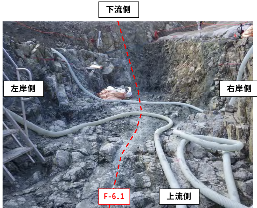
写真- 3.1.7 河床部下流側コアフィルター敷きの F-6.1 断層 幅 10cm～30cm 程度の灰色粘土部を含む CL1 級岩盤が幅 40cm～150cm 程度で分布する。
