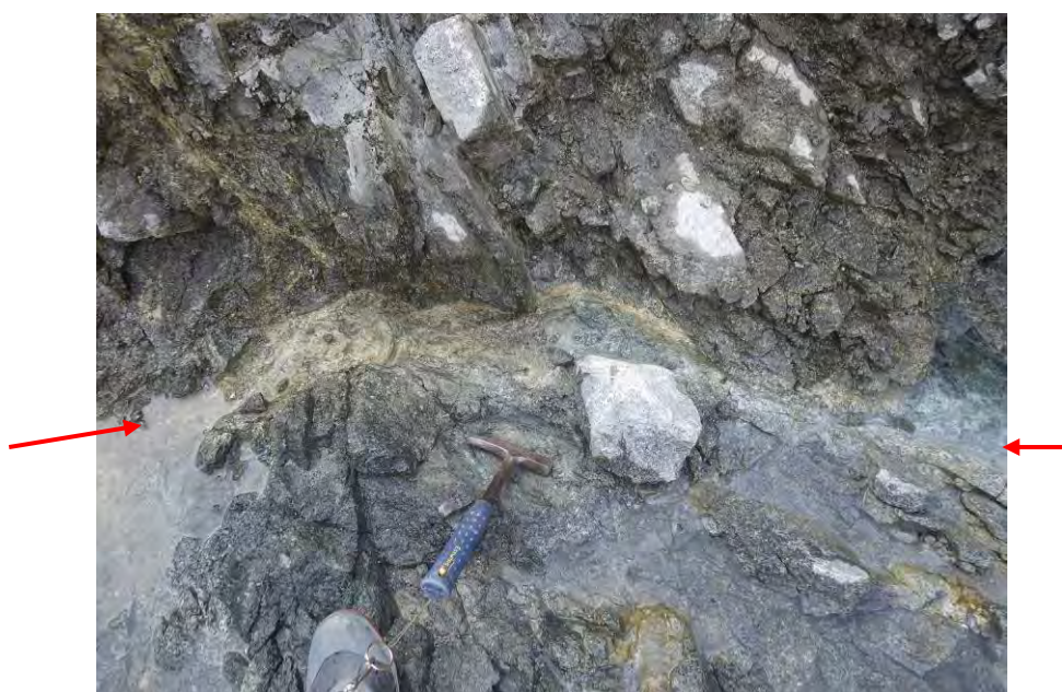
写真- 3.1.5 監査廊部の F-12.1 断層 幅 1cm～5cm 程度の灰色粘土部を含む CL1 級岩盤が幅 30cm 程度で分布する。
