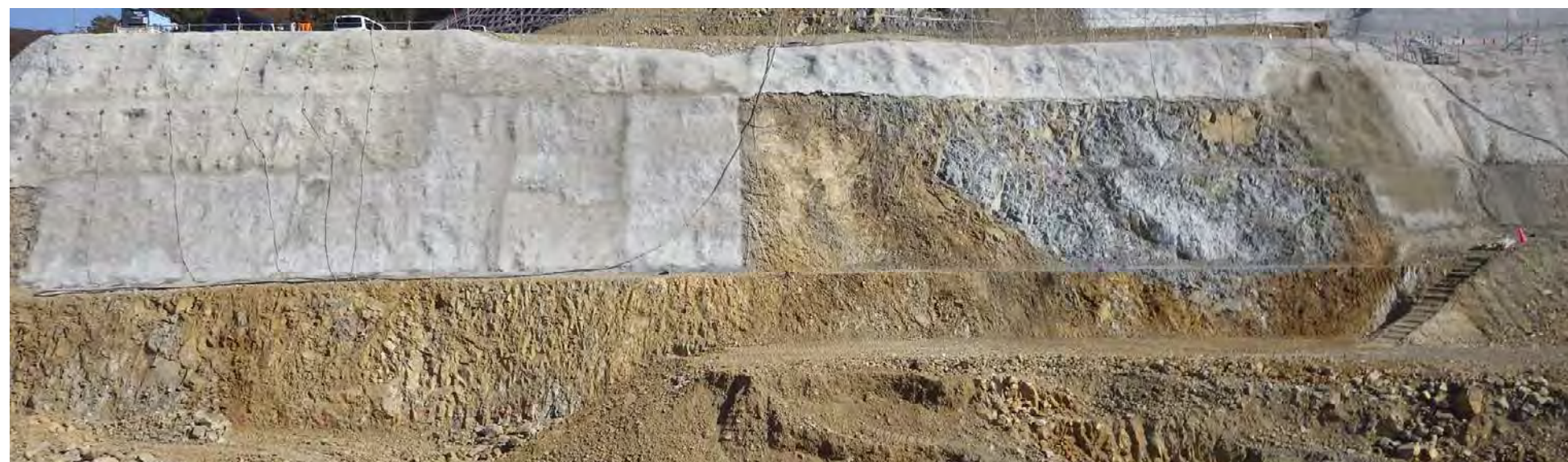
写真- 3.1.34 流入部~導流部 EL111m~124m 全景写真
