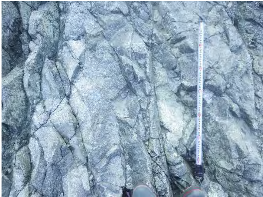
写真- 3.1.18 No.13+15・DC+1 付近の CM 級岩盤
