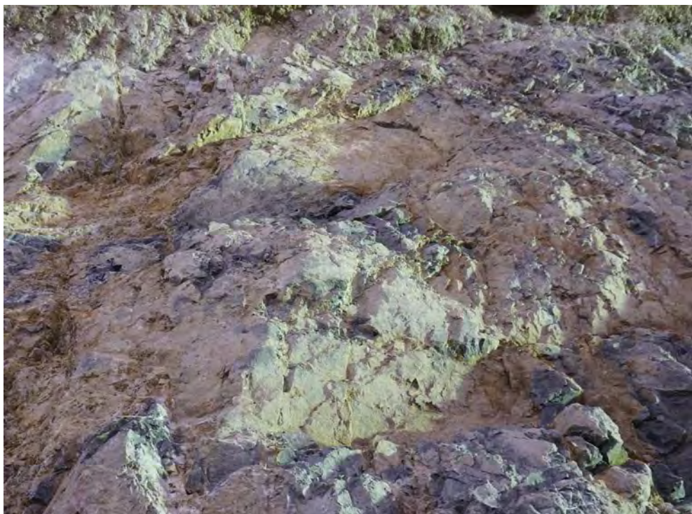
写真- 3.1.39 止水ライン付近の底盤部 ホルンフェルスが分布し、硬質な CM 級岩盤～CH 級岩盤が分布する。
