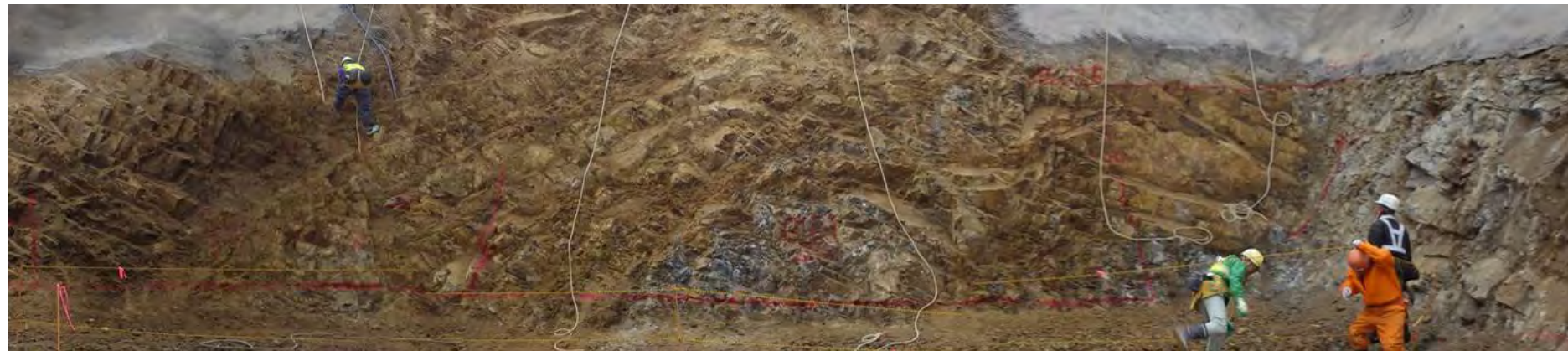
写真- 3.1.23 CL 付近～左岸側 全景写真
