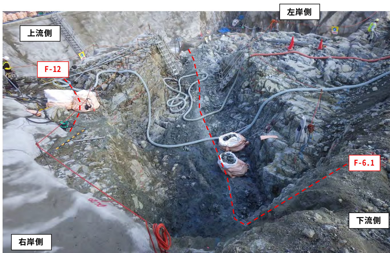
写真- 3.1.6 下流コアフィルター敷きの F-6.1 断層 設計仕上掘削面より深さ 170cm 掘削し、置換コンクリートで置き換える。
