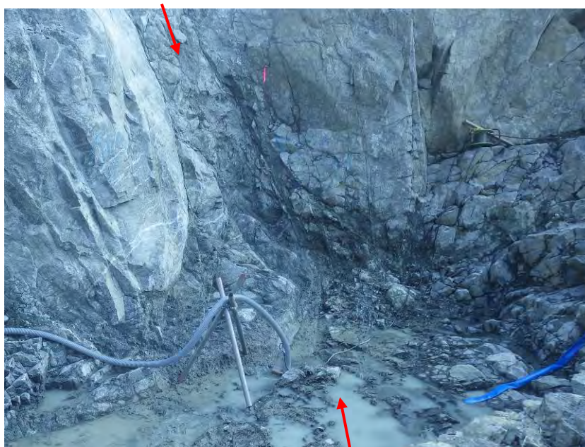
写真- 3.1.3 監査廊部～下流側壁面部の F-6.1 断層 幅 3cm～10cm 程度の灰色粘土部を含む CL1 級岩盤が幅 30cm～100cm 程度で分布する。
