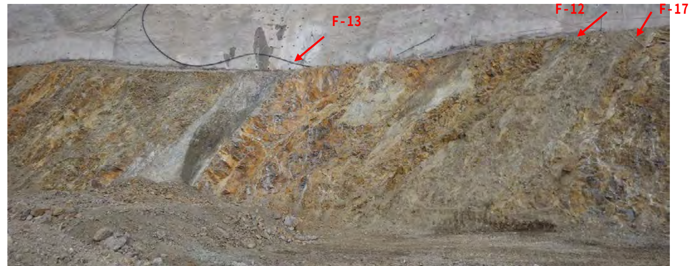
写真- 3.1.32 導流部 EL108.50m~117.50m 全景写真
