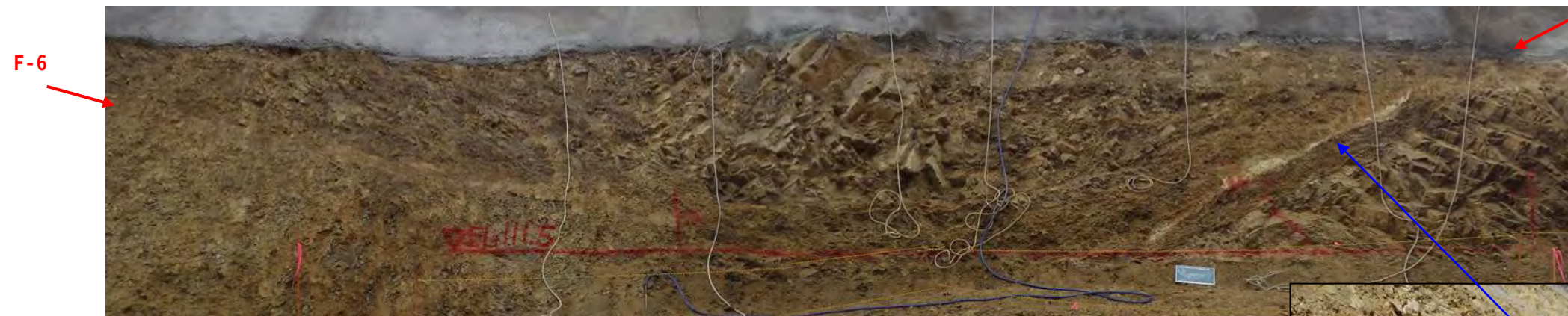
写真- 3.1.24 河床側～CL 付近 全景写真
