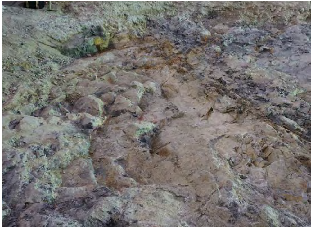
写真 - 3.1.40 下流側端部付近の底盤部 石英閃緑岩が分布し、割れ目が褐色化した CLh 級岩盤が分布する。
