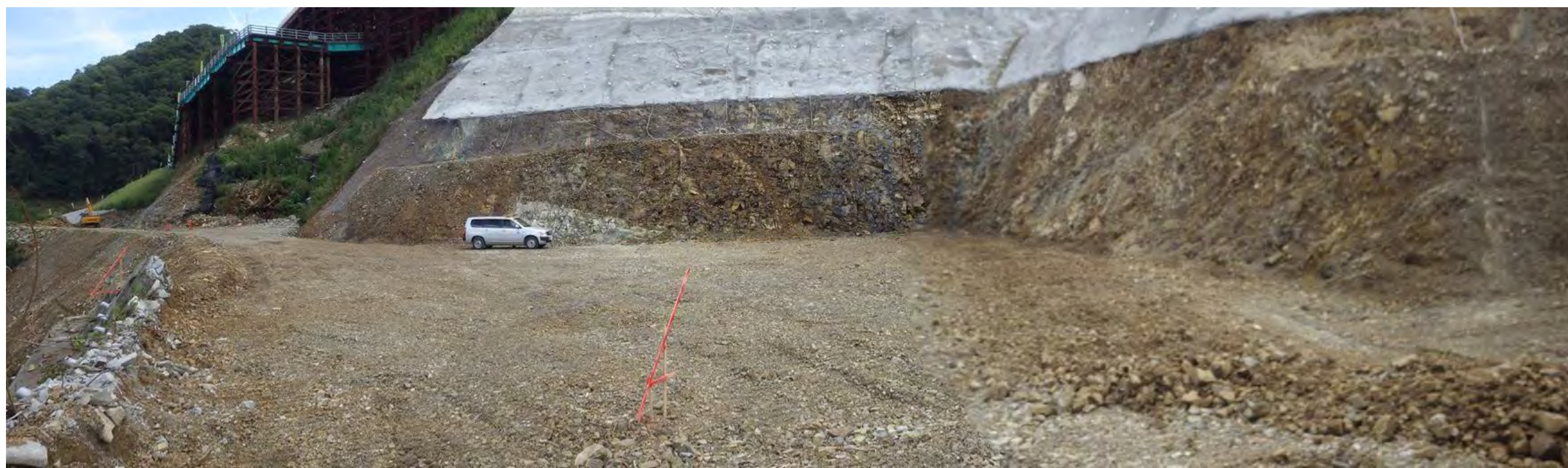
写真- 3.1.28 EL92.00m～100.00m（常用洪水吐き呑み口部） 全景写真
