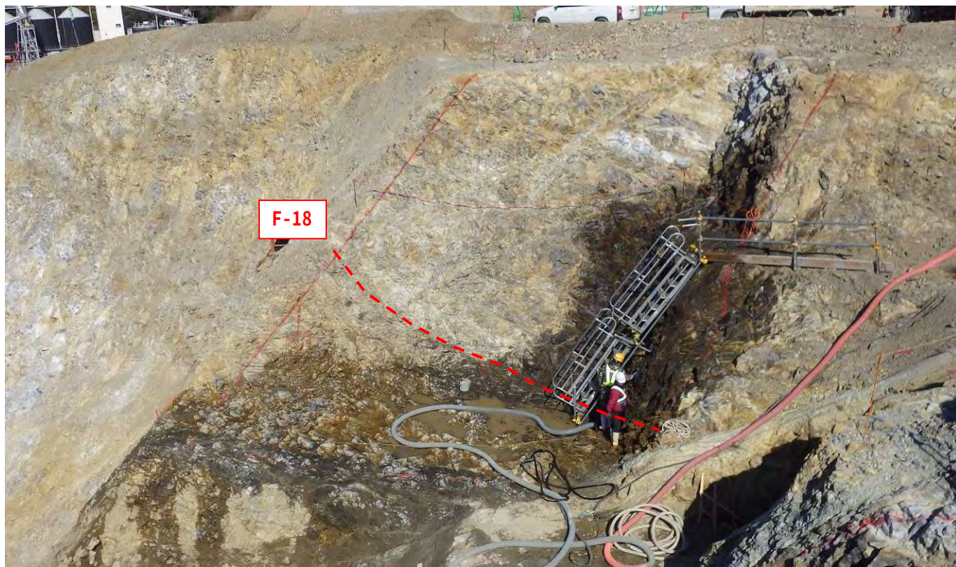
写真- 3.1.11 No.18 測線付近のコアフィルター敷き（上流側） 設計時に想定されていた CLl 級岩盤は掘削除去され、CLh 級岩盤主体となる。
