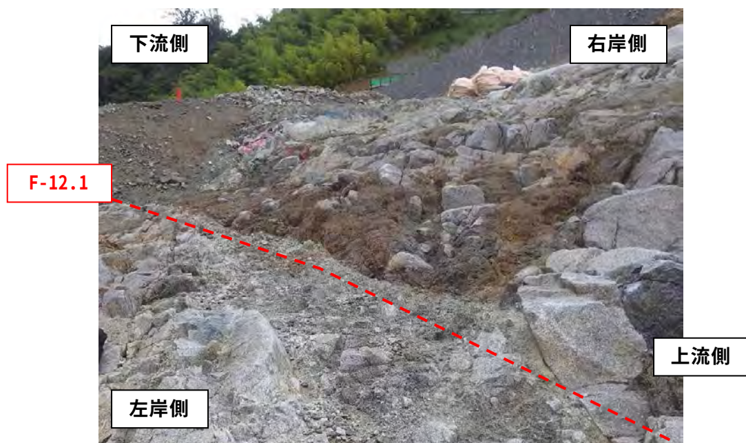
写真- 3.1.19 No.12+15・DC+15 付近の CLh 級岩盤 石英閃緑岩が分布しており、F-12.1 断層の右岸側には岩盤透水性区分の割れ目区分 γ 2bw に該当する割れ目が分布する（岩級区分：CLh 級岩盤(区分 CIIIc1)）。
