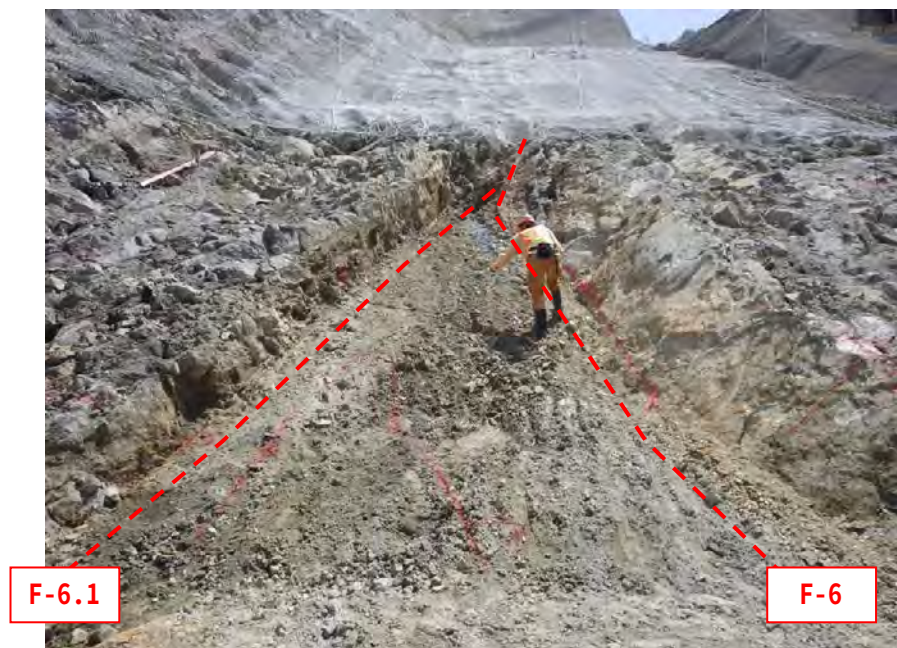
写真- 3.1.9 左岸上流側コアフィルター敷きの F-6 断層（設計仕上掘削面） F-6 断層と F-6.1 断層の分岐部付近に幅 200cm 程度の CL1 級岩盤が分布する。
