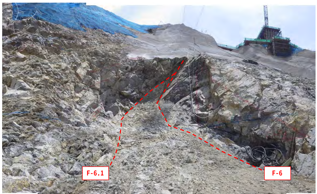
写真- 3.1.10 左岸上流側コアフィルター敷きの F-6 断層 設計仕上掘削面より深さ 200cm 掘削しており、置換コンクリートで置き換える。
