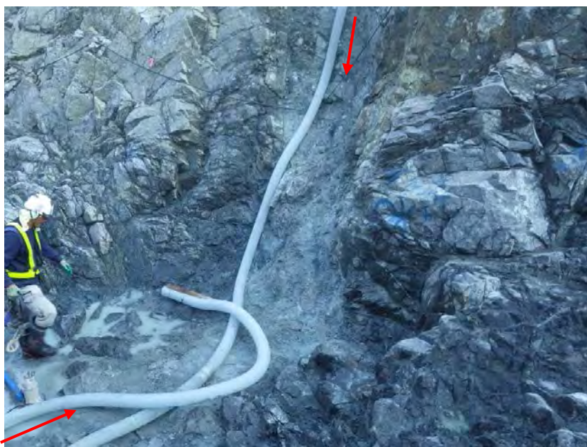
写真- 3.1.4 監査廊部～下流側壁面部の F-12 断層 幅 3cm～10cm 程度の灰色粘土部を含む CL1 級岩盤が幅 50cm～80cm 程度で分布する。
