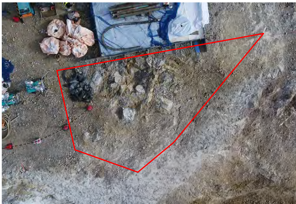
写真- 3.1.26 導流部の全景写真（赤枠内が本業務範囲）
