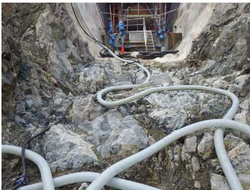
写真- 3.1.22 No.11+15・DC±0 付近の CM 級岩盤
