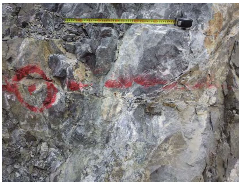
写真- 3.1.14 No.17+15・DC+12 付近の CM 級岩盤
