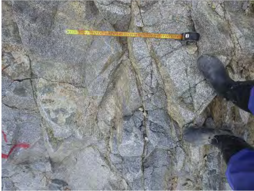
写真- 3.1.17 No.15+10・DC+10 付近の CM 級岩盤
