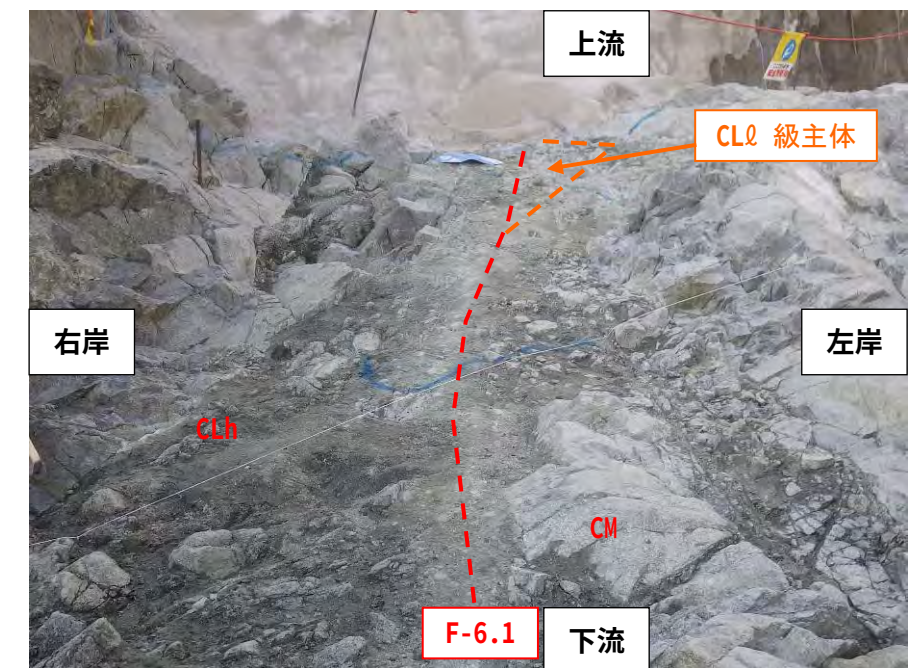
P.3 河床部下流側コア敷きの F-6.1 断層 左右岸方向の割れ目との合流部付近では、F-6.1 断層沿いに 最大幅 150cm 程度の CLl 級岩盤が分布する。
