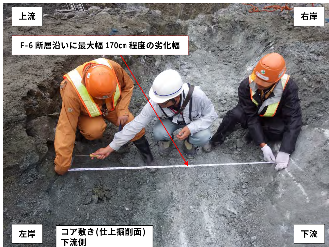
写真- 4.2.1 河床部下流側コア敷きの F-6 断層部分布状況 (No.13+8 付近)
