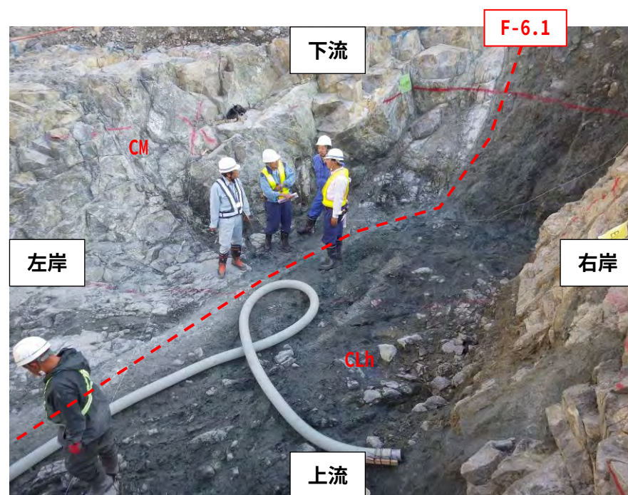
P.1 河床部下流側コア敷きの F-6.1 断層 断層より左岸側は CM 級岩盤、右岸側は CLh 級岩盤主体となる。
