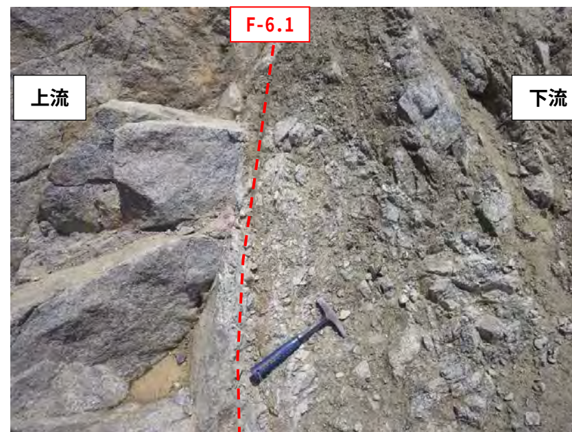
P.2 F-6.1 断層 幅 3cm 程度の灰色粘土部を伴う。 断層より上流側は CM 級岩盤主体となる。
