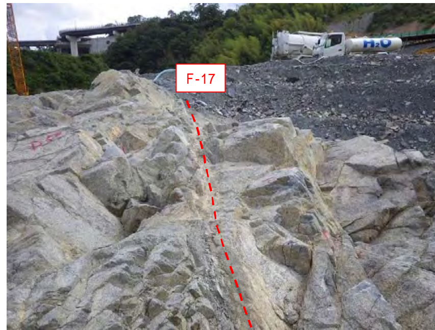
P.1 F-17 断層 断層沿いに幅 30cm ~ 50cm 程度の劣化幅 (CL級岩盤) が分布する。 (確認日: 平成 30 年 5 月 29 日)
