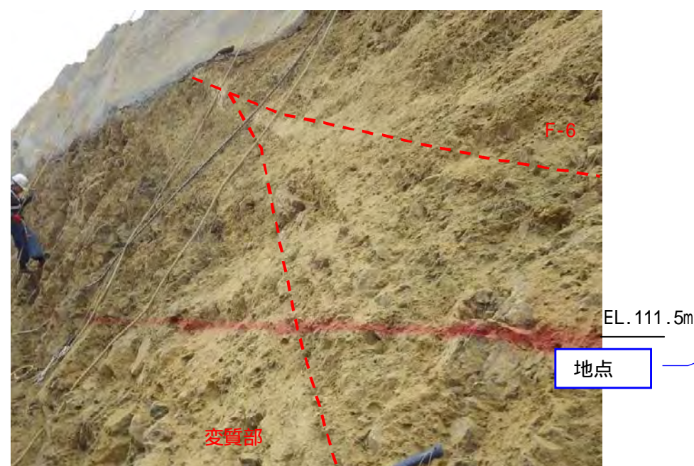
P.4 変質部 EL.111.5m 付近では、劣化幅（D 級）は狭くなり、幅 5cm 以下となる。
