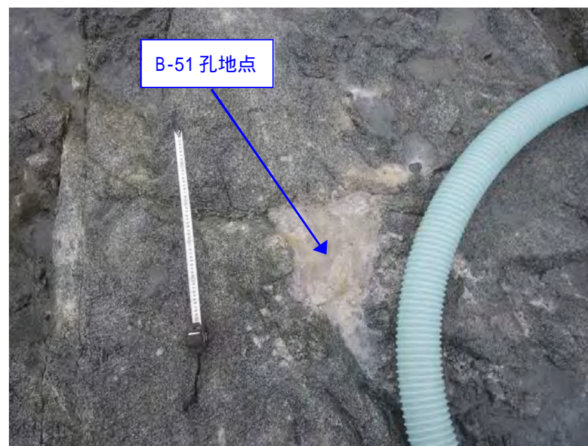
P.3 B-51 孔 孔埋め (止水処理) を実施し、周囲から湧水は認められない。 (確認日: 平成 30 年 5 月 29 日)
