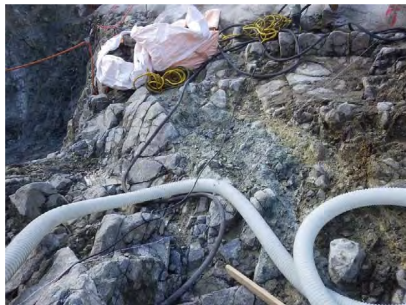
P.1 F-12 断層 幅 5cm～10cm 程度の灰色粘土部を含む。 (確認日：平成 30 年 10 月 24 日)
