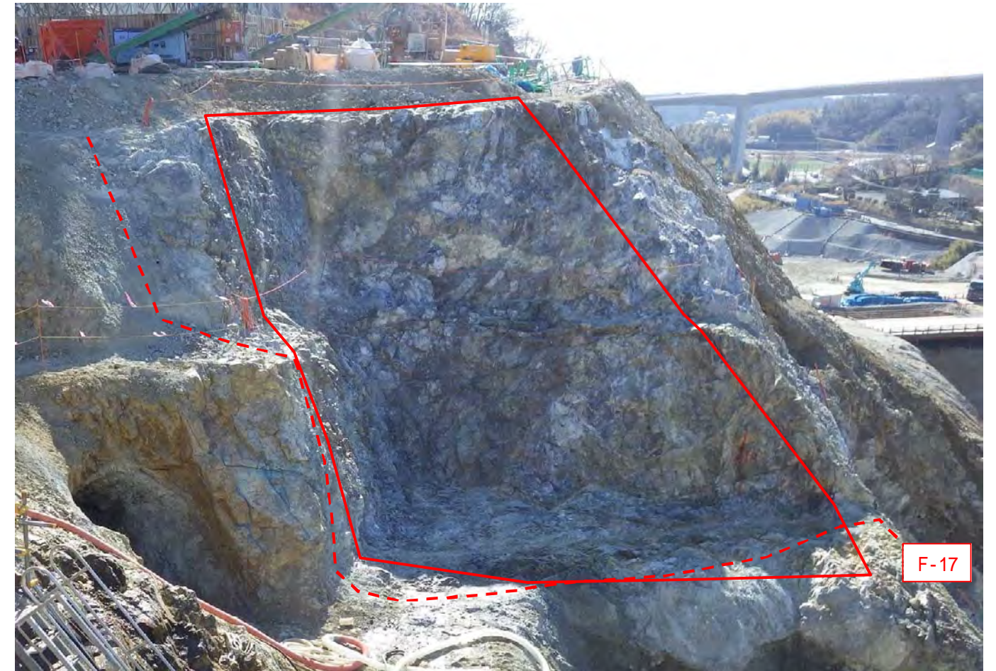
P.6 下流側全景写真 割れ目は概ね新鮮であり、CM 級岩盤主体となる。 (確認日：平成 30 年 2 月 7 日)
