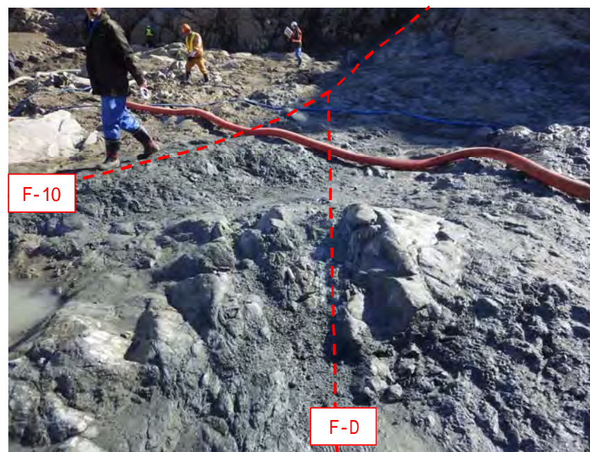
P.3 F-D 断層 F-10 断層により分断される。
