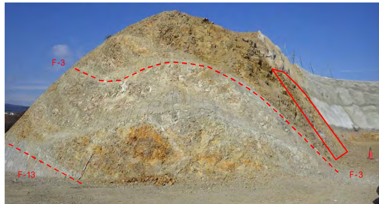
P.2 下流側端部の法面状況（今回の対象範囲外） F-3 断層（及び F-13 断層）が分布しており、CL o 級岩盤～CLh 級岩盤主体となる。 （確認日：平成 29 年 12 月 19 日）
