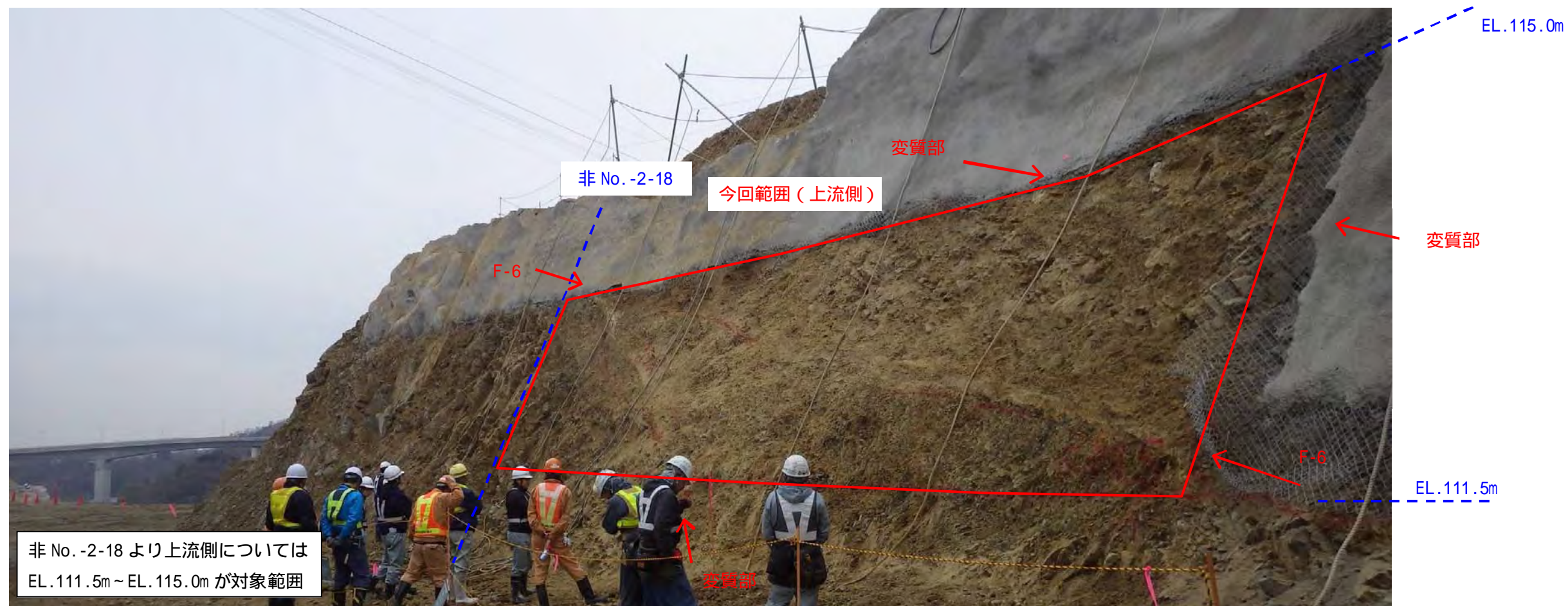
P.3 今回範囲（上流側）の全景写真 既往範囲に連続する F-6 断層が分布する。（確認日：平成 29 年 12 月 8 日）
