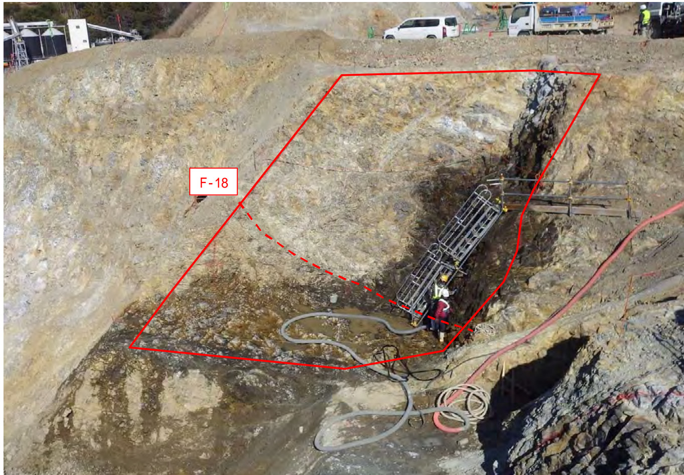
P.5 上流側全景写真 下流側より割れ目が褐色化しており、CLh 級岩盤主体となる。 (確認日：平成 30 年 2 月 7 日)
