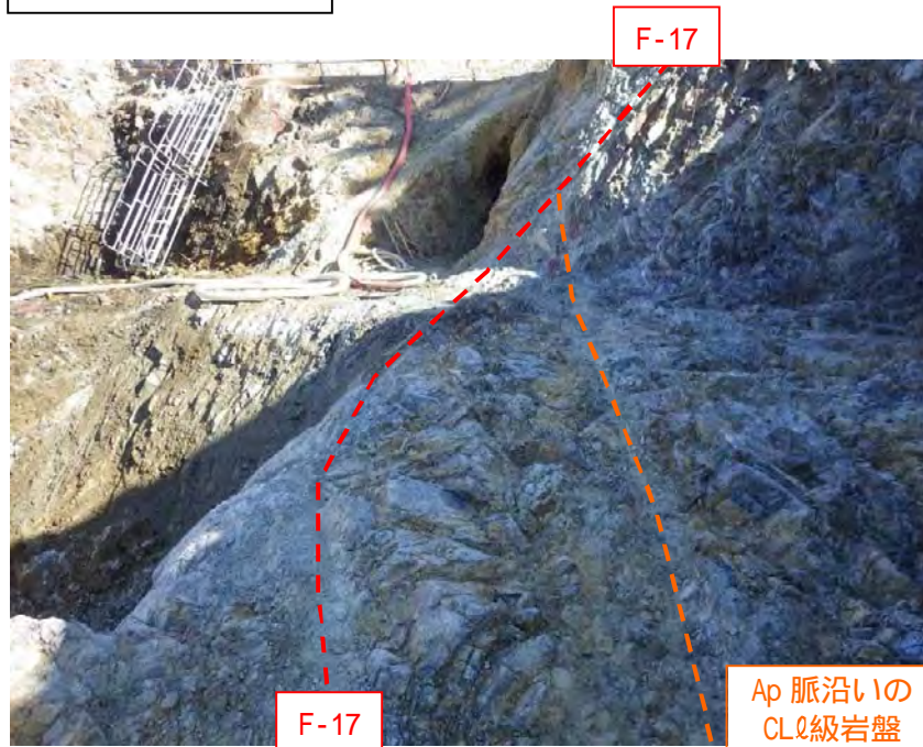
P.1 F-17 断層及びアプライト脈沿いの CL 級岩盤 アプライト脈沿いの CL 級岩盤は、 山側壁面にて F-17 断層に分断される。 (確認日：平成 30 年 2 月 7 日)
