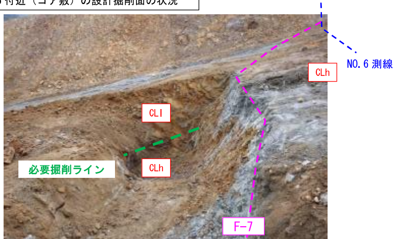
No. 6 付近（コア敷）の設計掘削面の状況
