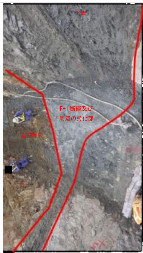
F-1 断層監査廊敷の状況
