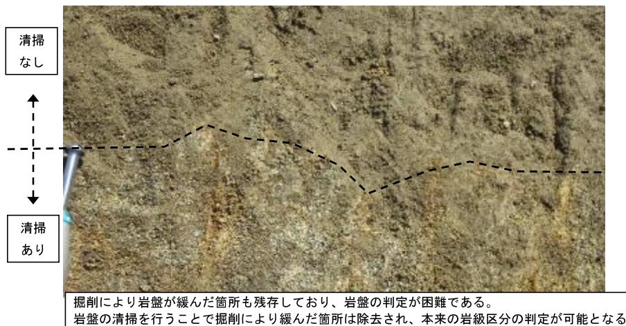
ロック敷きにおける岩盤清掃
