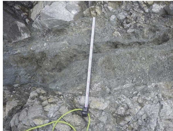
P.1 F-6 断層 幅 70cm 程度の D 級岩盤が分布する。 (確認日：令和元年6月18日)
