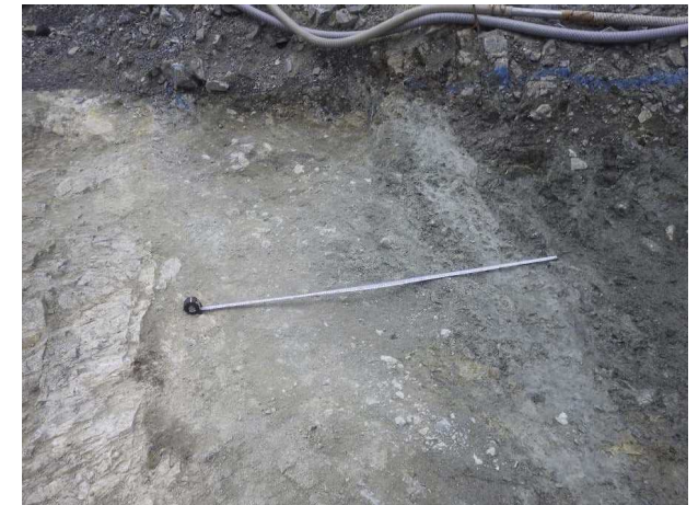
P. 2 F-6 断層の近接写真 幅 170cm 程度の D 級岩盤が分布する。
