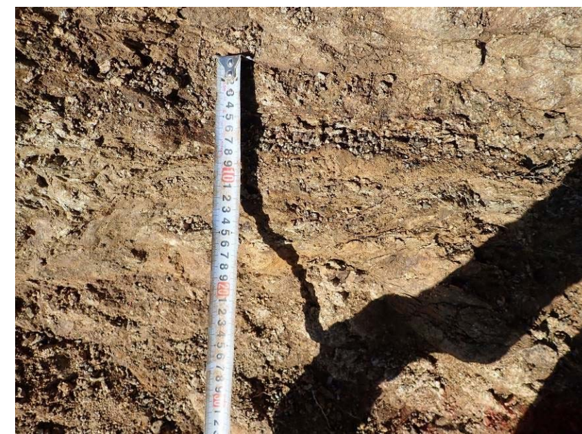
Pic.2 F-C 断層の近接写真
