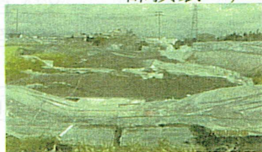
パイプハウス被害(八幡市)
