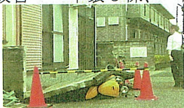
ブロック塀倒壊(長岡京市)
