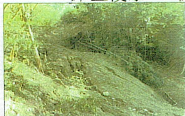
林地被害(亀岡市)
